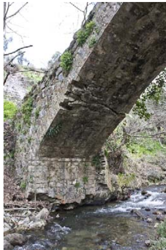
Τα θεμέλια της γέφυρας, έχουν επικίνδυνα κλινισθεί από τα νερά του ποταμού.
